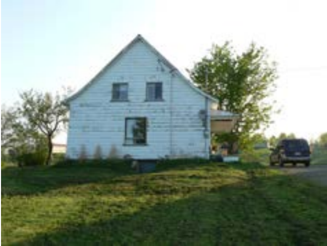
Figure 1 : Façade avant (sud-ouest) du bâtiment en 2012. Photo du propriétaire.
