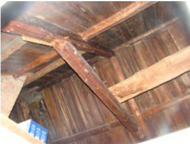
Figure 15: Charpente à tenons, mortaises et chevilles de bois.
