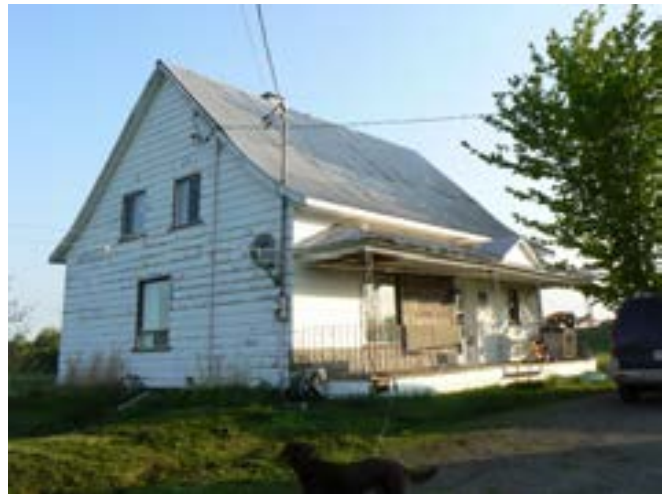
Figure 4 : Façade sud-est du bâtiment en 2012. Photo du propriétaire.
