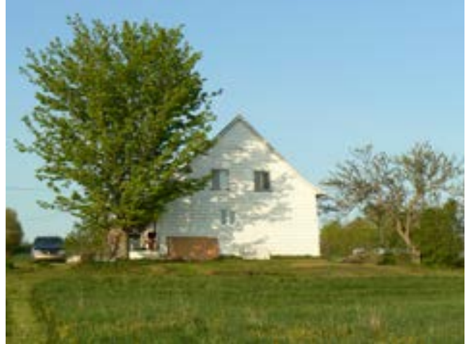
Figure 2 : Façade arrière (nord-est) du bâtiment en 2012. Photo du propriétaire.
