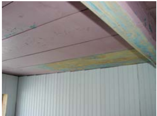
Figure 18: Finis originaux de l'étage à conserver et restaurer. Le décapage des finis jusqu'au bois n'est pas nécessaire. La couleur bleue est un témoignage de l'ancienneté du bâtiment.
