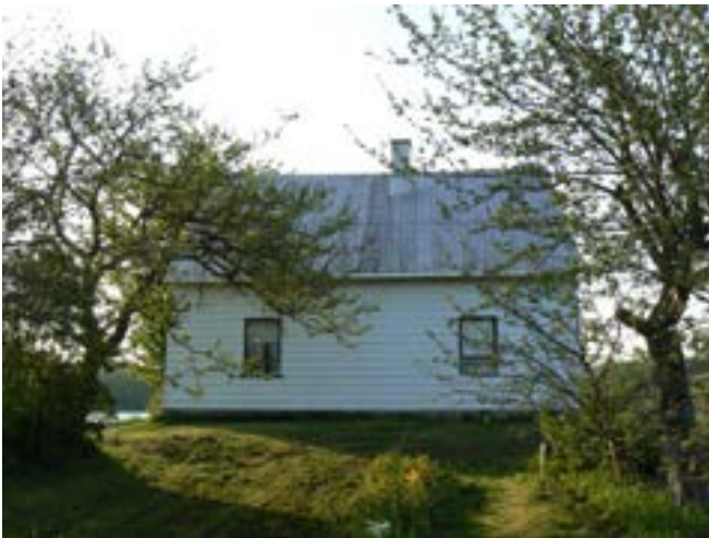
Figure 3 : Façade nord-ouest du bâtiment en 2012. Photo du propriétaire
