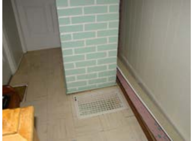
Figure 14: Déformation structurelle importante visible près de la cheminée de l'étage.
